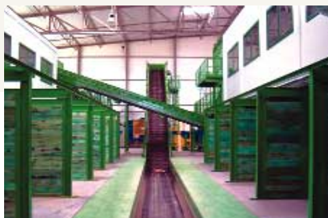
Sortownia odpadów surowcowych
